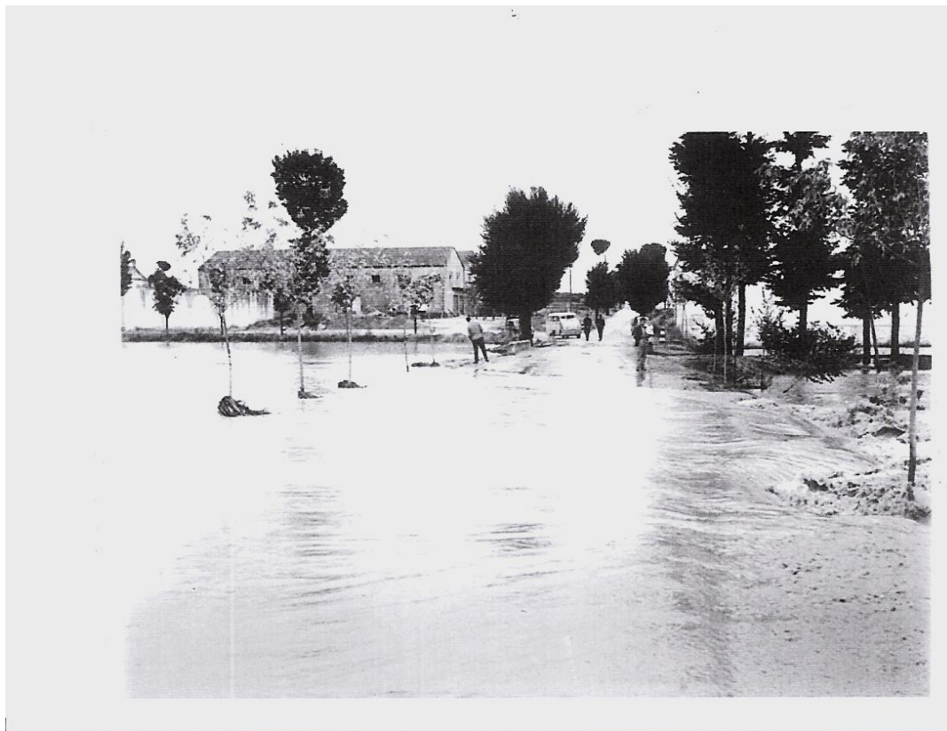
Figura 7. Avenida o riada (coloquialmente “venía” o “riá”) del Riato en octubre del año 1982. Cayó una tromba de agua de 96 l/m 2 en la cuenca del Valdemembra y se produjo en Tarazona una riada de 200 m en ambas margenes del Riato, llegando el agua hasta la calle Pascasio Quilez. Autor desconocido
