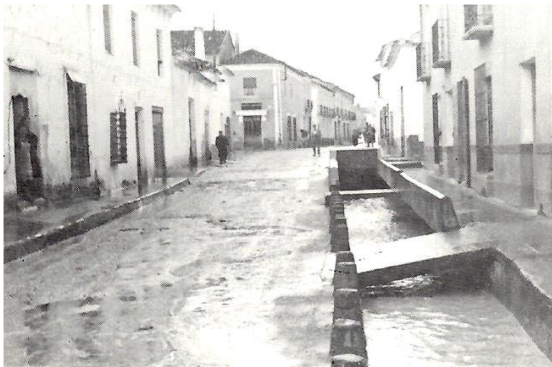
Figura 6.- Aspecto de las cunetas y de la salida de un colector en la Rambla baja con ocasión de una lluvia intensa. Años 60. Foto Andrés Muñoz "Tito"
