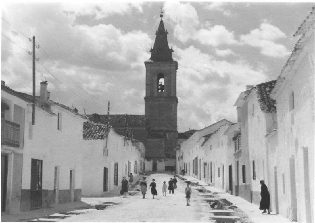
Figura 4.- Cunetas de la Calle Villanueva de Tarazona de la Mancha. Fotografía de los años 60. Autor Andrés Muñoz "Tito"
