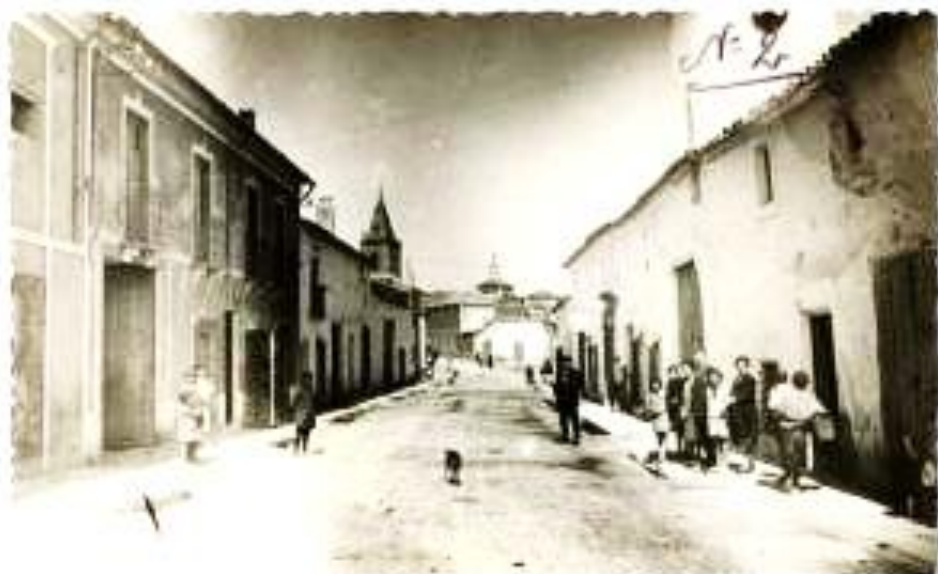
Figura 5.- Cunetas descubiertas en la Calle La Virgen; la mayoría de las casas que se muestran se han transformado completamente. Autor: Damián Mondéjar, por el año 1940. Tomada de "Fotos Antiguas". Ayuntamiento de Tarazona
